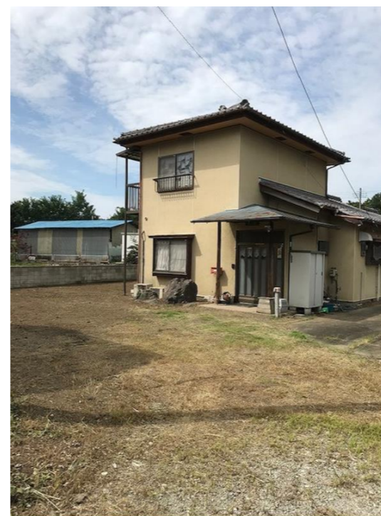
↑ 建物(解体予定)
